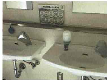
自動水栓蛇口 (右写真奥は、手動の蛇口で、使い分け)
