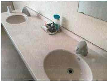
自動水栓蛇口 (右写真奥は、手動の蛇口で、使い分け)
